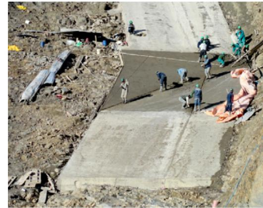
Colocado de hormigón de Regularización Plinto
