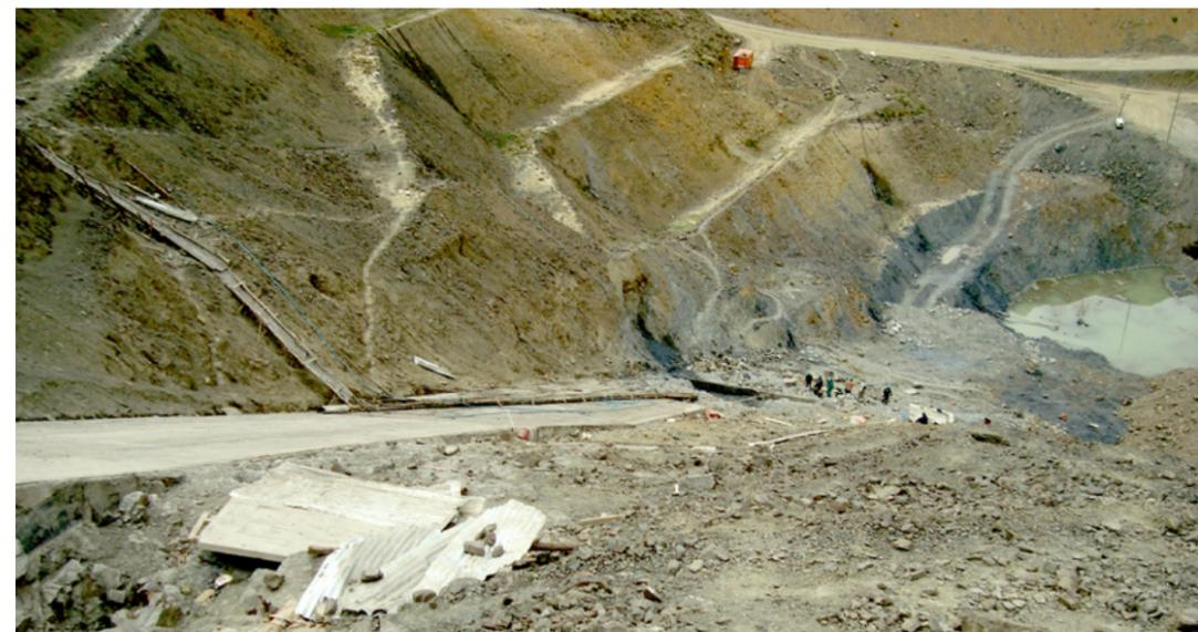
Hormigón de regularización estribo derecho
