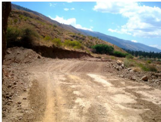
Por otro lado, se colocaron alcantarillas en la quebrada Rojas Mayu para evitar el arrastre de material fino. La plataforma del camino de acceso fue estabilizado con material rocoso, se reencusaron las quebradas para evitar afectaciones a parcelas, infraestructura y los accesos habilitados.
