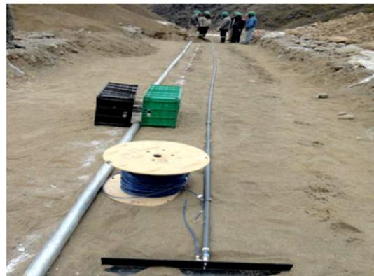
Extensómetro de Hilo Vibrátil
