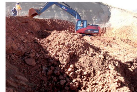
Excavación del Pozo de compuertas
