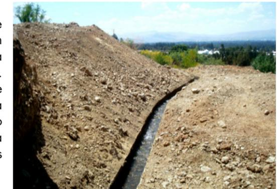
Antes de la temporada de lluvias, se retiró el material depositado sobre el canal de riego en inmediaciones del rio Chijllaviri, que por procesos de arrastre de material en la epoca de lluvias, hubiera obstruido el canal y desviado las aguas provocando erosion y deslizamientos en el sector.
