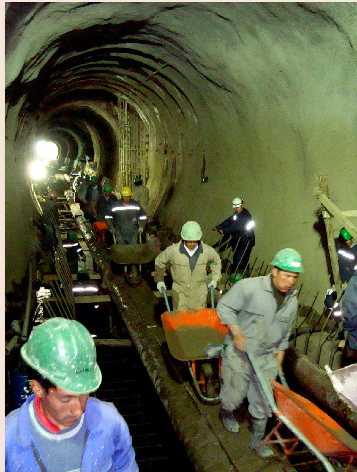
Hormigonado solera tunel de desvío
