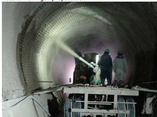
**Foto 3:** Hormigón proyectado hastiales prog. 0+095
