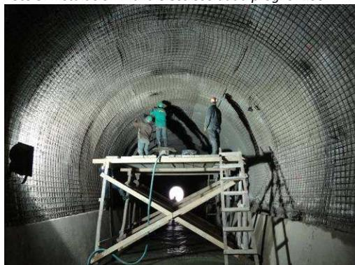
**Foto 6:** Instalación barras de fijación prog. 0+090
