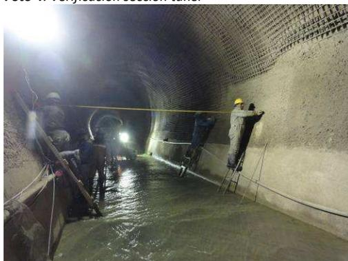
**Foto 5:** Instalación malla electrosoldada prog. 0+100
