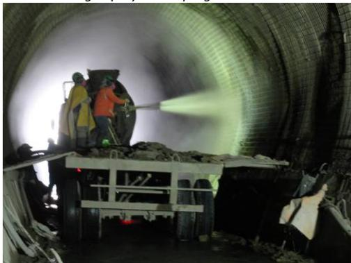
**Foto 4:** Instalación malla electro soldada prog. 0+0340
