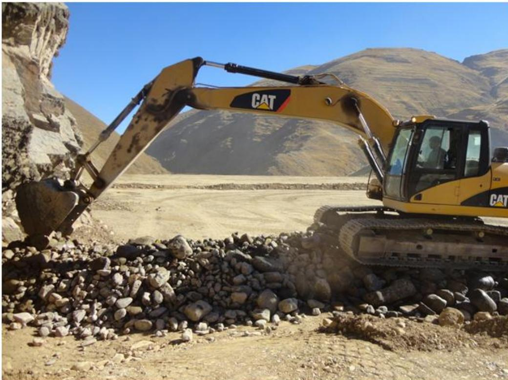
**Extendido de material E, sector Ataguía aguas abajo, en la cota 3669.40 m.s.n.m. 26-07-2012**
