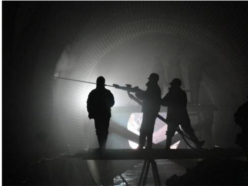
**Foto 2:** Hormigón proyectado progresiva 0+025
