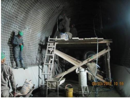
Foto 8: Instalación ganchos de fijación progresiva 0+315
