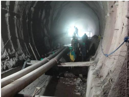
**Foto 6:** Limpieza con agua y aire en cámara de válvulas
