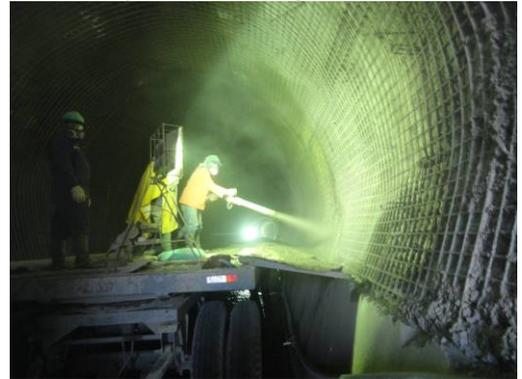
**Foto 3:** Hormigón proyectado progresiva 0+055
