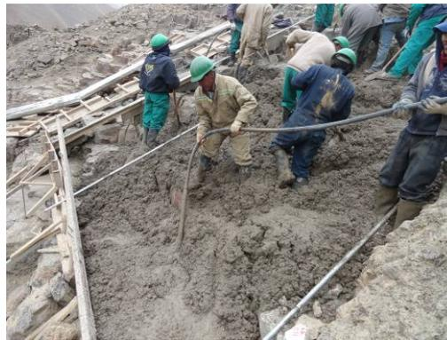
**Foto 4:** Superficie concluida de regularización - hormigón dental
